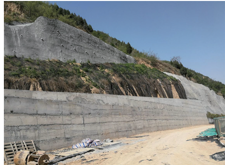
(a) I 分段坡体治理工程现状
