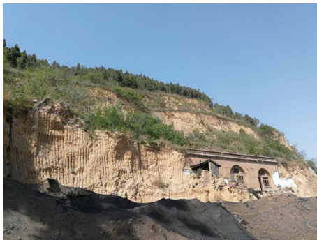
(b) II 分段坡体临空面现状 2
