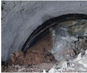
图3 开挖时掌子面围岩情况
