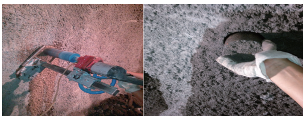
图 4 试验喷射混凝土钻芯取样图
